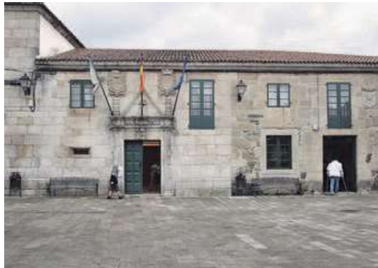
El pavimento de la Praza do Convento será reformado. XOÁN A. SOLER
